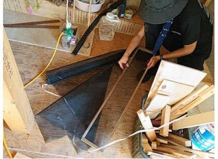
午後は網戸づくり。10箇所それぞれの窓の大きさを測って木枠をつくり、ホームセンターで買った網戸張り替え用の網をタッカーで打ちつける。これでいちおう「網戸」ができる（左下写真）。それを窓枠にビスで固定していけばよい。版築壁のおかげで室内の気温は外よりはマシ（2～4度くらい低い）だが、それでも作業をしていると汗がどばどば出てくるので、頻繁に休憩をとった。じつとしているだけで、さっきまで滝のように出ていた汗がひいてくれた。北森さんは「暑さにもだんだん慣れてきますね。人体の神秘ですね」と言っていた。暗くなる前に網戸は完成し、窓枠に打ちつけた。北森さんは帰宅。
